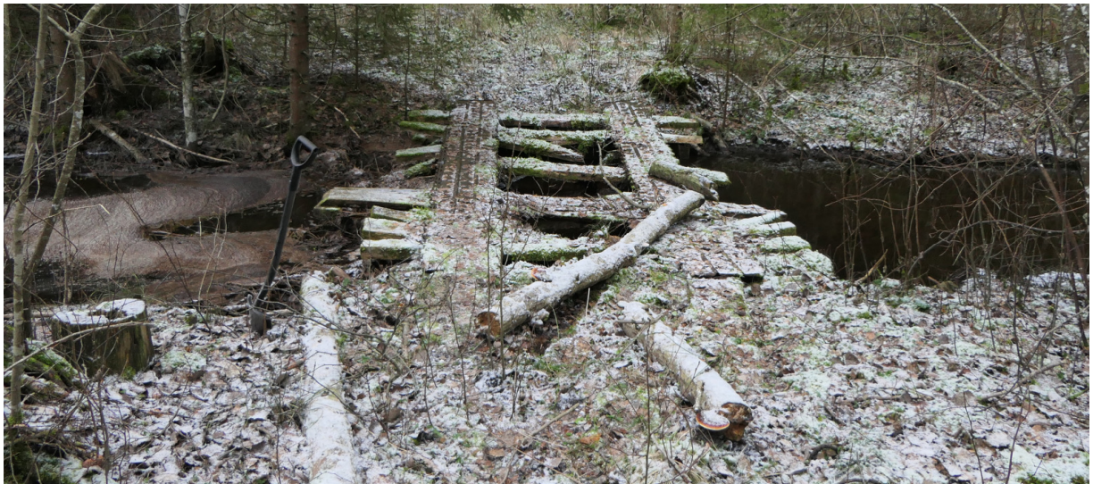
Foto 2. Sillavare Külvandi kinnistul
